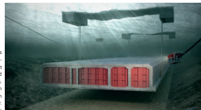
Visualisierung des Absenkvorgangs eines Tunnелеlements. Solche Elemente sind bis zur Verbindung mit den jeweils anderen vorbeigehend mit wasserdrichten Schotten versehen. Später verhilfen Gummidichtungen zwischen den einzelnen Elementen die Eindringen von Wasser. Grafik: Sund & Balt
